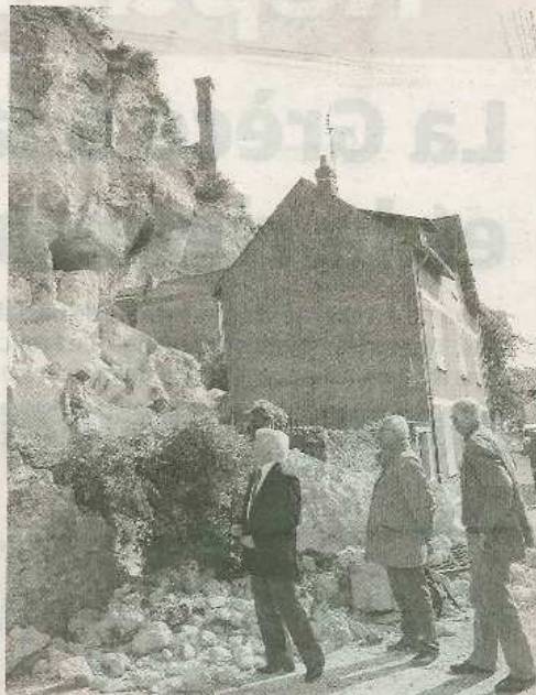
Les nouvelles expertises réalisées hier ont abouti à un constat alarmiste : des risques d'éboulement subsistent.
